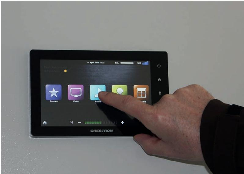
Seitens des Anwenders können zusätzliche Szenen angelegt und gespeichert werden. Die Steuerung der Jalousien wurde der Einfachheit halber in Gruppen zusammen gefasst. Auch der Bühnenvorhang kann direkt über die Touchpanel gefahren werden. Die Heizungssteuerung erfolgt über eine Direktansprache des 0-10 V Heizungsreglers.
